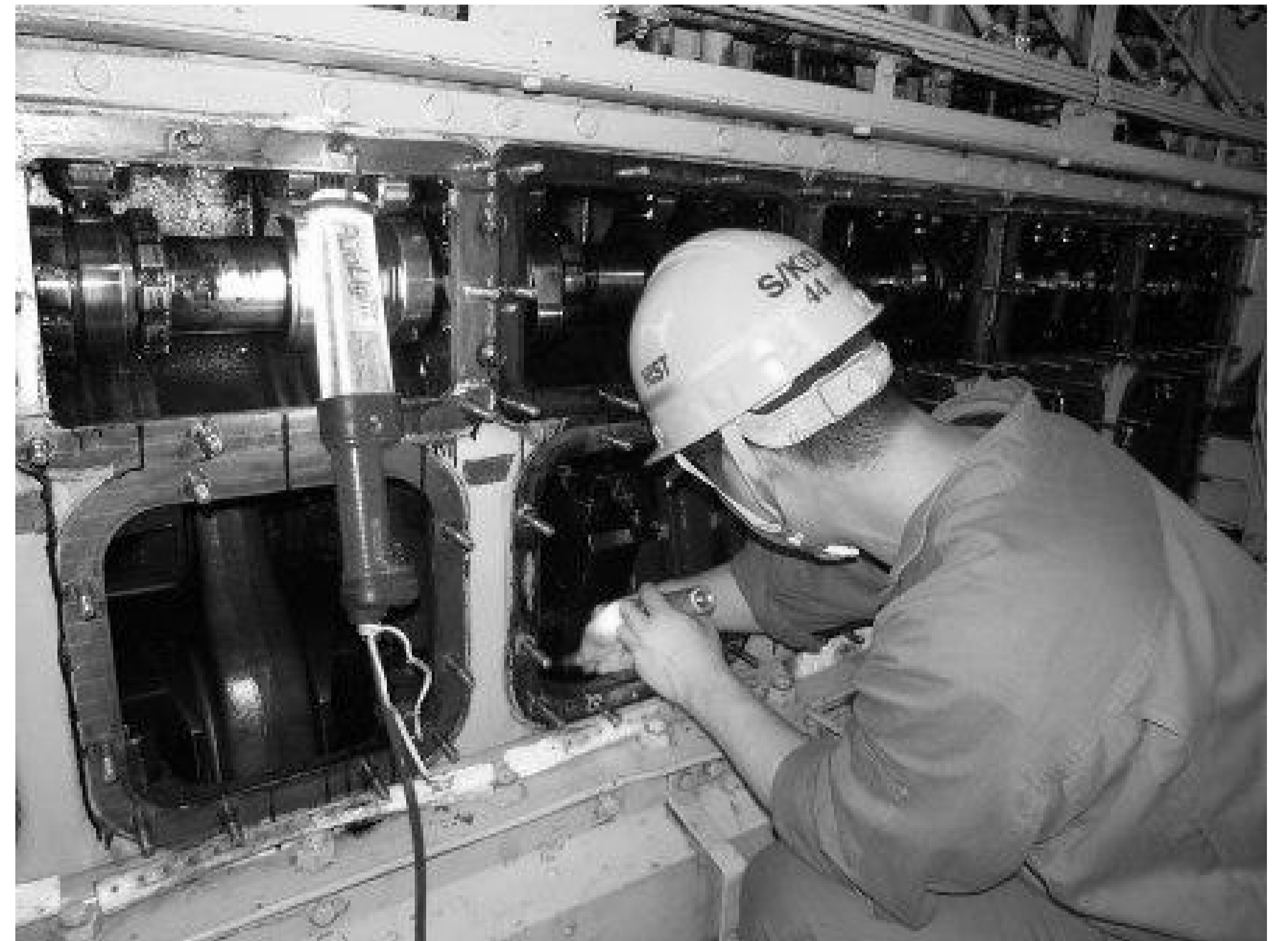
写真1 機関点検の様子
