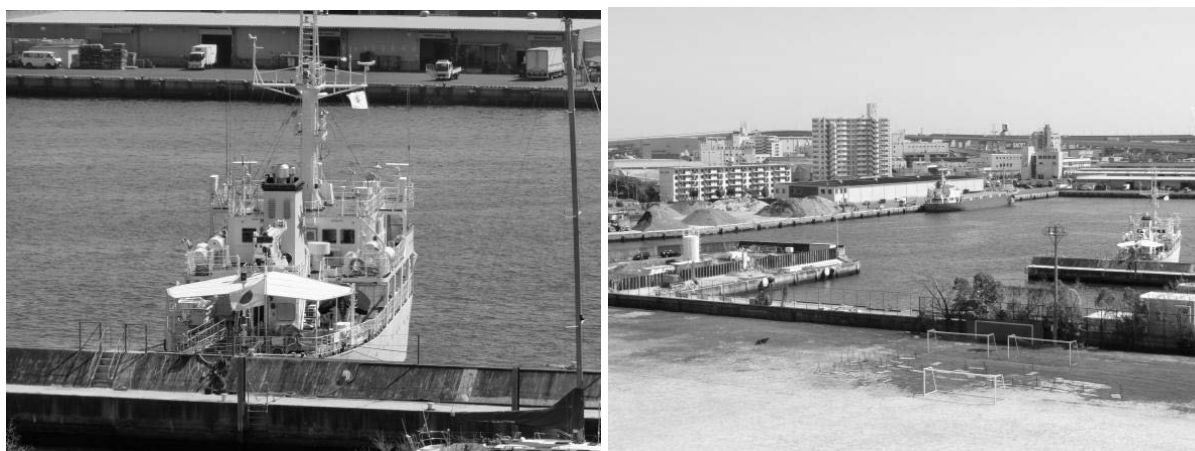
図 7-1 深江丸の防波堤への船尾係留（ポンド浚渫中）
