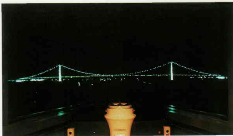
図3 明石架橋夜間照明実験
