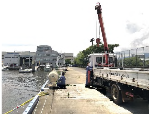
写真7 ラフト架台の設置
