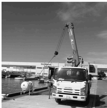
写真7 ラフト架台の設置
